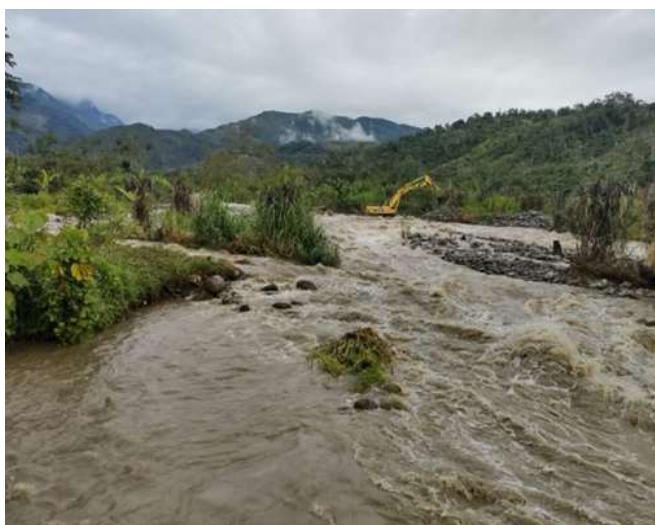
FIGURA N°03: VISTA PANORÁMICA DEL CAUCE DEL RÍO CUSCOMAYO. LOS TALUDES DE AMBAS MÁRGENES SON INESTABLES, PROPENSOS A EROSIÓN. EL MATERIAL DE COMPOSICIÓN DE CAUCE SON EN SU MAYORÍA BOLONERÍA, CANTO RODADO Y ARENA.
